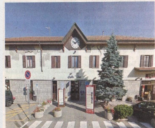
La stazione ferroviaria di Oulx
